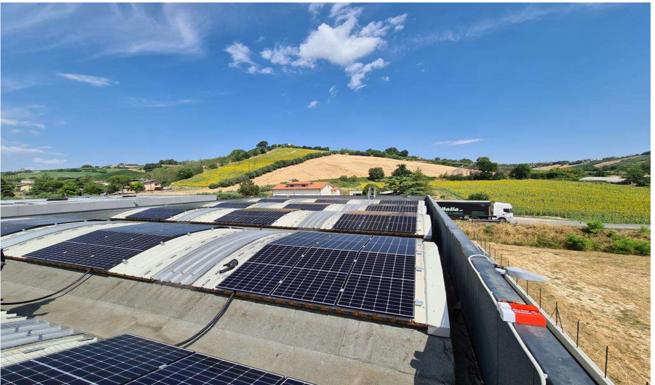
Petricoli impianto su opificio industriale kWp 72
