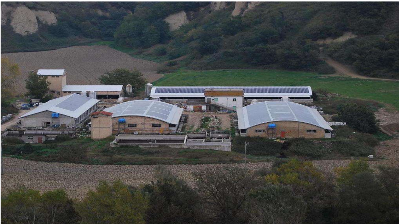
Atri impianto a film sottile su porcilaia da 100 kwp
